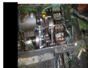
Fig.5 - grupa 4 a contactelor fixe ruptă
