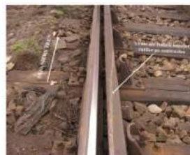
Foto nr.4 – Urme de rulare pe contrasină
