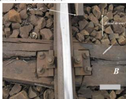
Foto nr.16 - Traversa B
