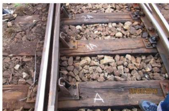
Foto nr.15 - Traversa A
